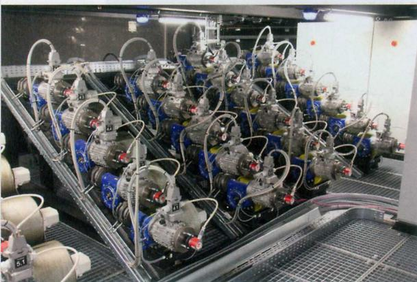
**Obermaschinerie für die neue Bühne: 76 Punktzüge in 13 Reihen sorgen für Flexibilität im Spiel- und Probenbetrieb**
