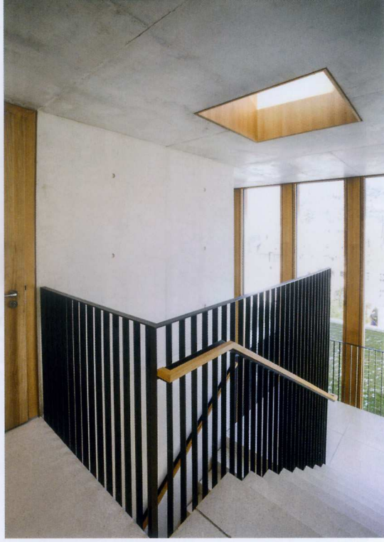
Boden und Treppenstufen sind mit der gleichen Betonrezeptur gefertigt.
