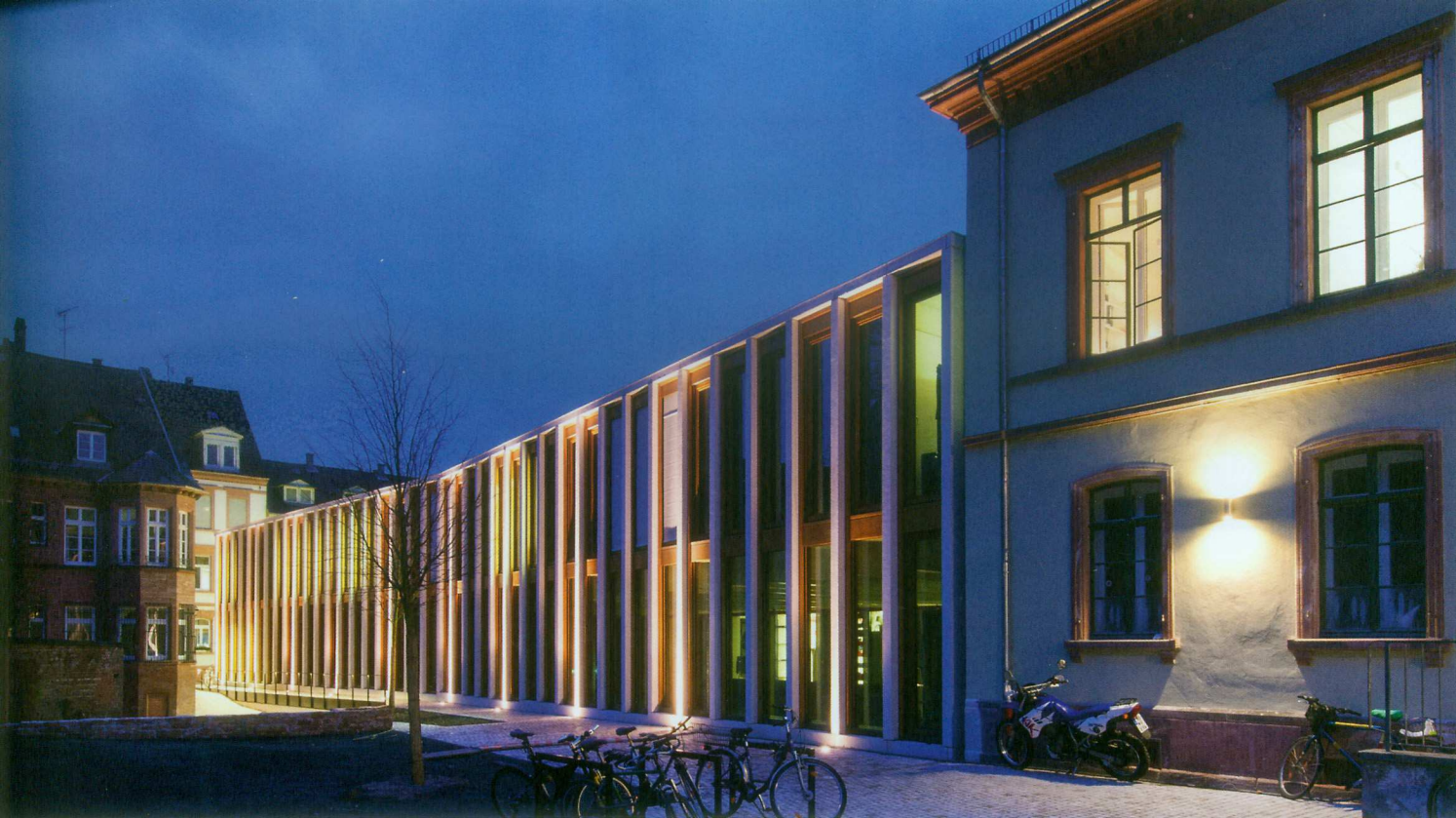
Stützen aus Sichtbeton gliedern die Neubaufassade des Heidelberger Theaters und fügen sich an die sanierten Bestandsgebäude, die ebenfalls für den Theaterbetrieb in der Altstadt genutzt werden.
