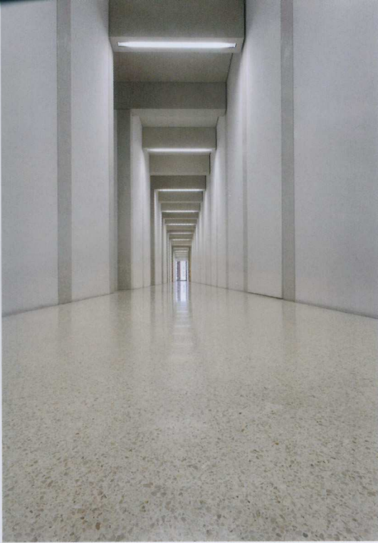
Der elegante Betonboden zeigt die geschliffenen Partikel des Kalksteins Ulmer Weiß mit einer Körnung von maximal fünf Millimetern Durchmesser.
