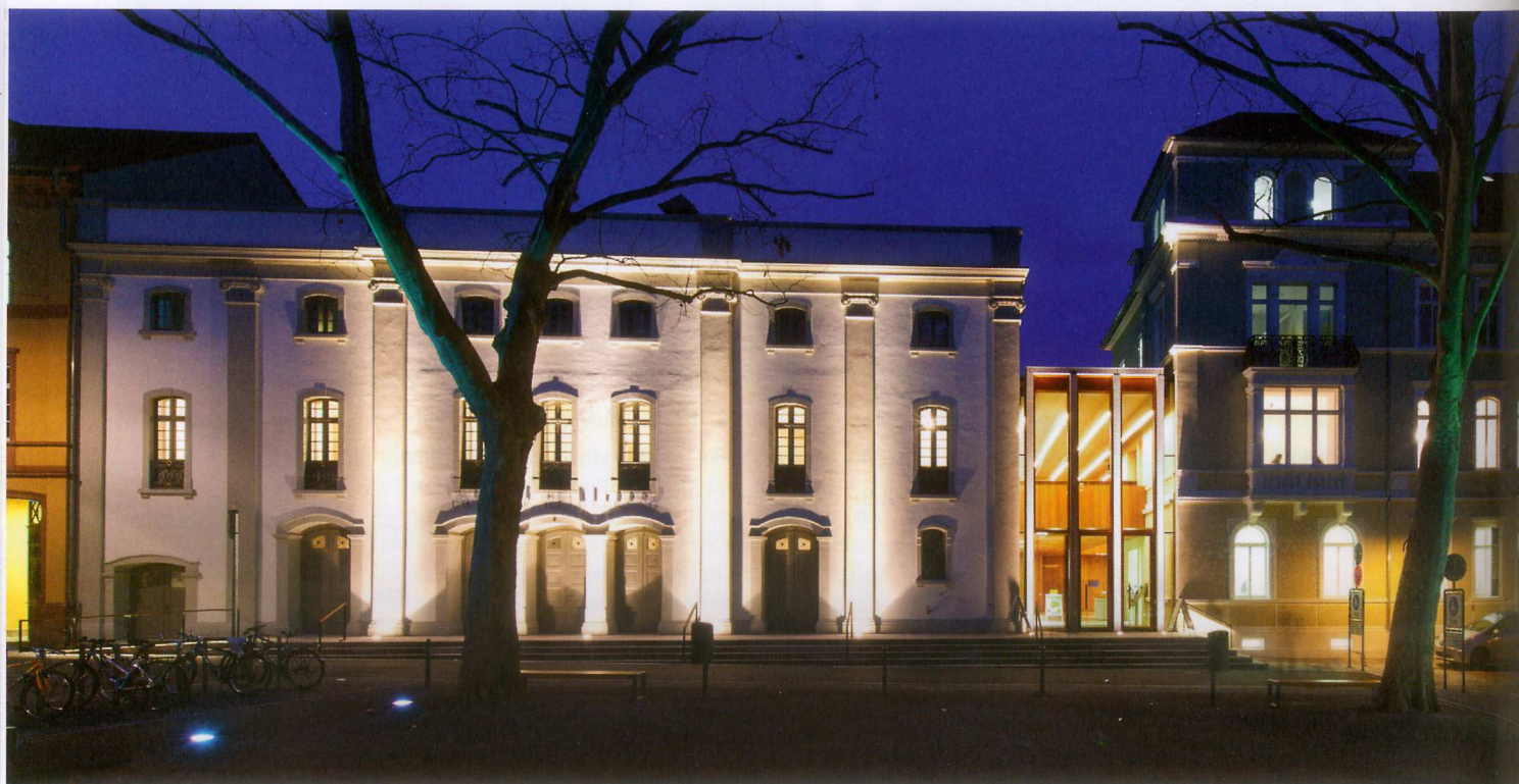
Das gesamte Neubauvolumen fügt sich in die Kubatur der kleinteiligen Heidelberger Altstadt ein.
