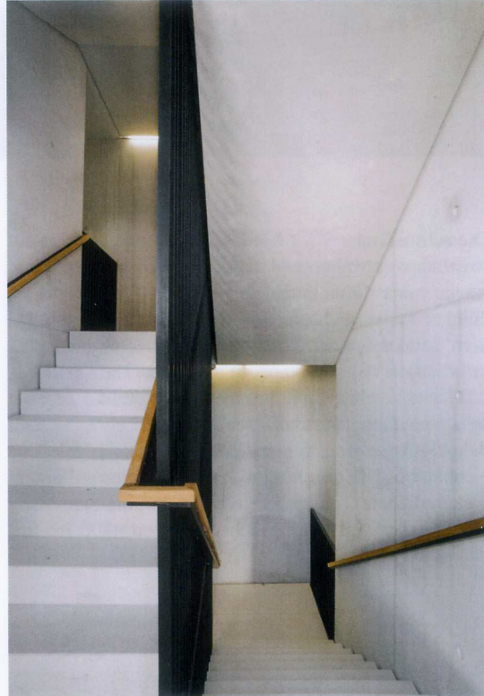
Die Treppenstufen wurden im Betonwerk vorgefertigt. Der Boden kommt in der entsprechenden Rezeptur aus dem Transportbetonwerk.
