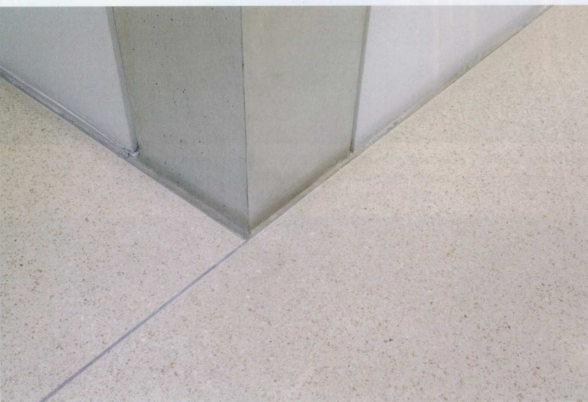
Mittels Aluminiumschienen werden verschiedene Bodenflächen, die bis zu 100 m 2 groß sind, gelungen aneinander gefügt. Die Abstandsfuge zur Wand wird flexibel verschlossen.
