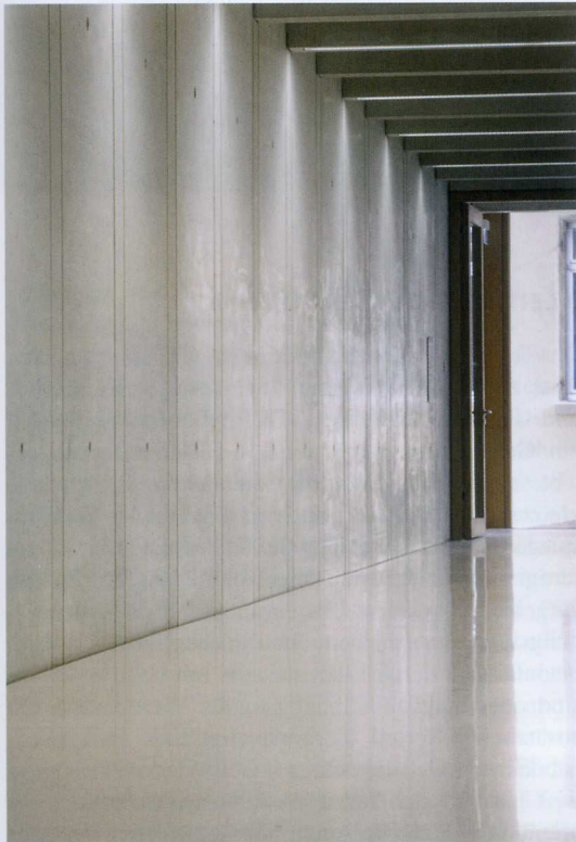
Der helle Betonboden korrespondiert mit den glatten Sichtbetonwandflächen im Theaterneubau.
