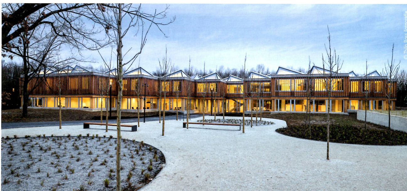
Abb. 1: Auf Augenhöhe mit dem Kottenforst präsentiert sich die clusterartige Holzskelettkonstruktion des neuen Campus in Bonn
