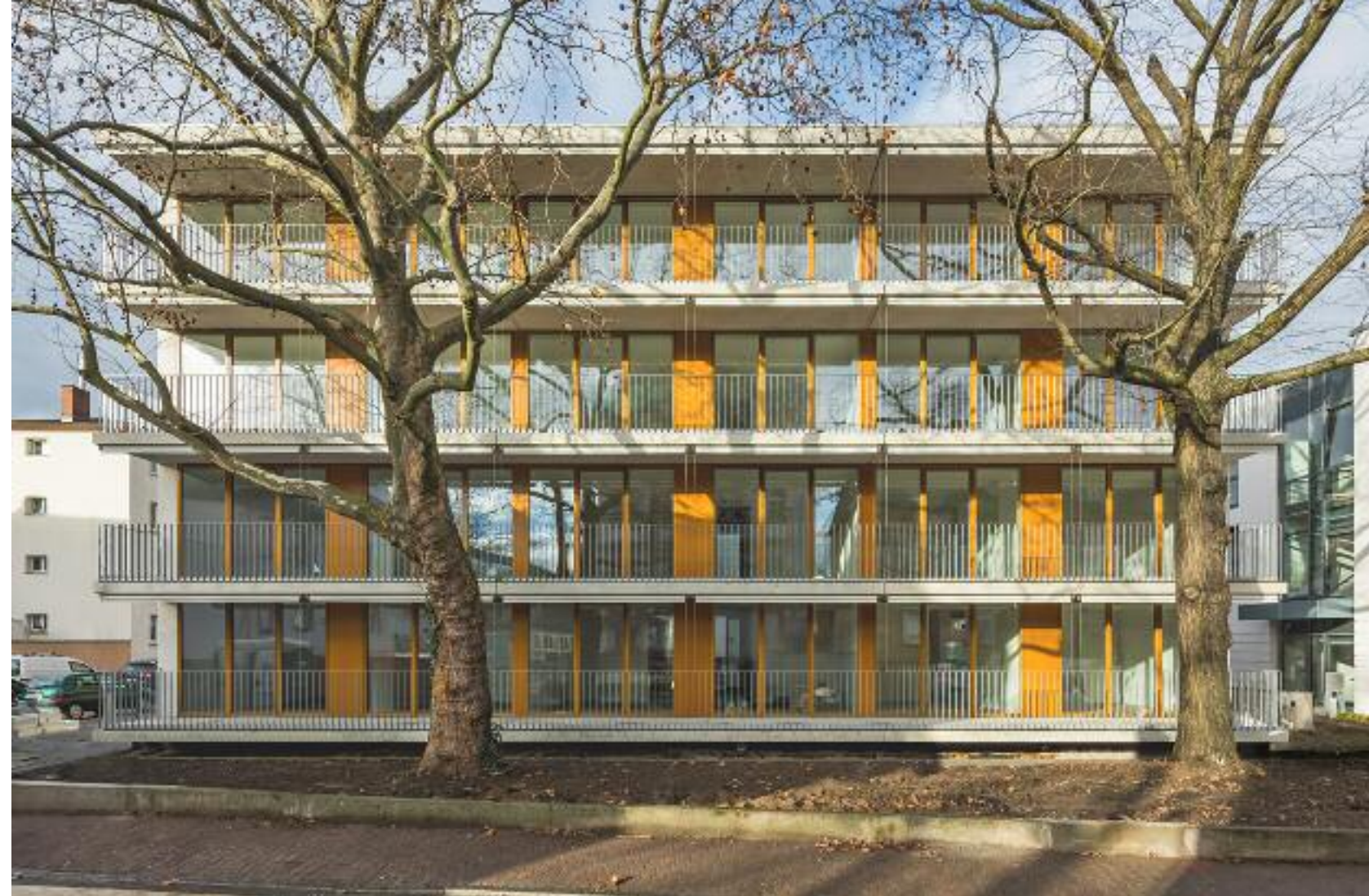
Das Seniorenwohnhaus ist baukastenartig in Schottenbauweise mit kurzen Spannweiten und einfachen Fügungen und Details ausgeführt. Damit kamen die Vorteile der Vorfertigung zum Tragen, das heißt das Projekt ließ sich wirtschaftlich und schnell realisieren.
